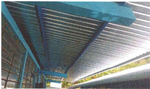
Foto 1: En la gráfica se observa la parte frontal del módulo 1 con la instalación de lámina troquelada calibre 26 y mantenimiento de cubierta de techo.
