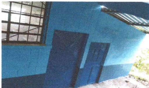
Foto 3: Trabajos realizados en módulo de cocina con sustitución de estructura de techo y cubierta de lámina, además de repello y cernido de paredes.
