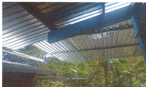
Foto 5: Remozamiento en espacio anexa al módulo de cocina en colocación de estructura de techo y cubierta de lámina.
