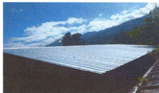
Foto 2: En la gráfica se aprecia el módulo priorizado en el renglón de trabajo cubierta de lámina con la instalación de lámina troquelada calibre 26.
